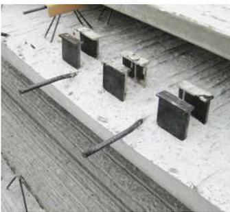
**Les rails et douilles** sont principalement utilisés dans les dalles de couverture des cages d'ascenseur. Ces 2 inserts sont directement intégrés dans les prédalles en usine et complétés avec des armatures de renforts sur chantier dans la dalle de compression. Ils sont demandés par l'ascensoriste qui les utilise comme point de fixation en sous-face de la prédalle lors des phases d'entretien des gaines d'ascenseur.
