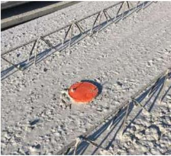
**Les inserts électriques** de type « plots de centre CAPRI® » pour les luminaires, et des réservations 10X10 cm pour les descentes de gaines dans les cloisons.
