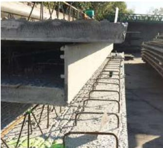
**Les bords relevés** avec ou sans larmier sont intégrés à la prédalle pour réaliser le coffrage de rive. Ils sont principalement utilisés pour les prédalles de fond de coffrage des balcons en porte-à-faux.
