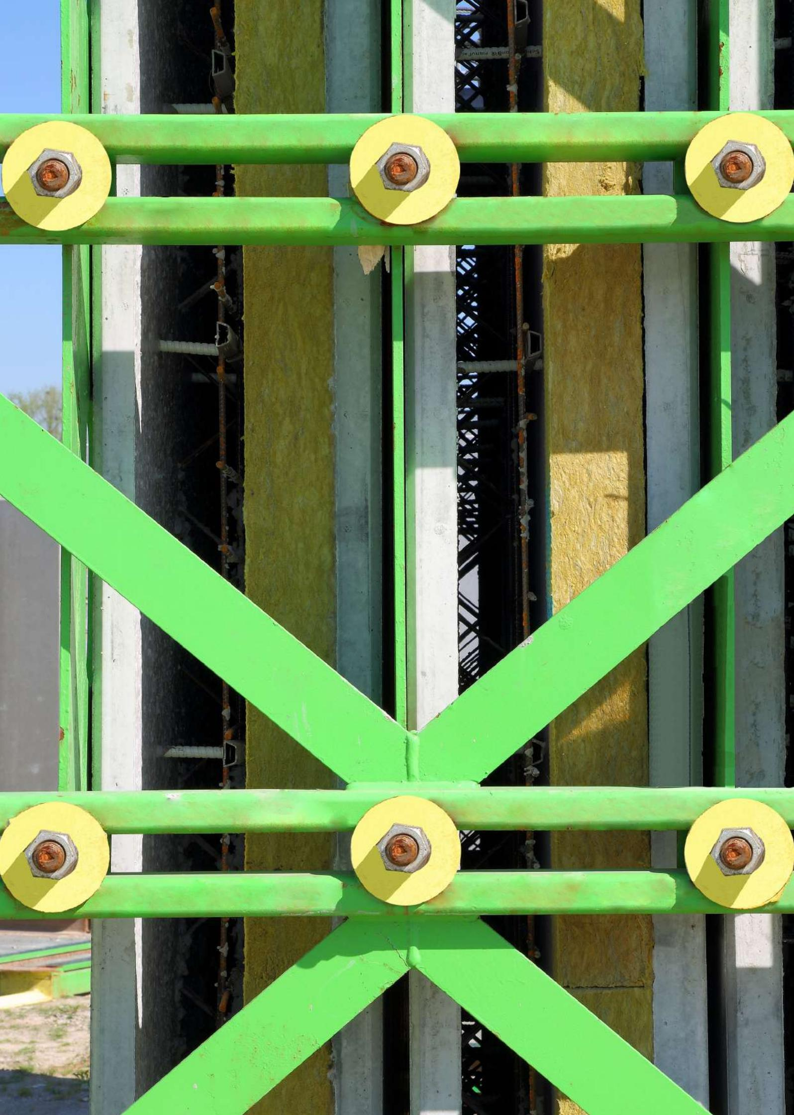
Die Beton-Außenschale der Thermowand gewährleistet stabilen Schutz für den Dämmstoff und damit eine besondere Langlebigkeit bei reduziertem Wartungsaufwand.
