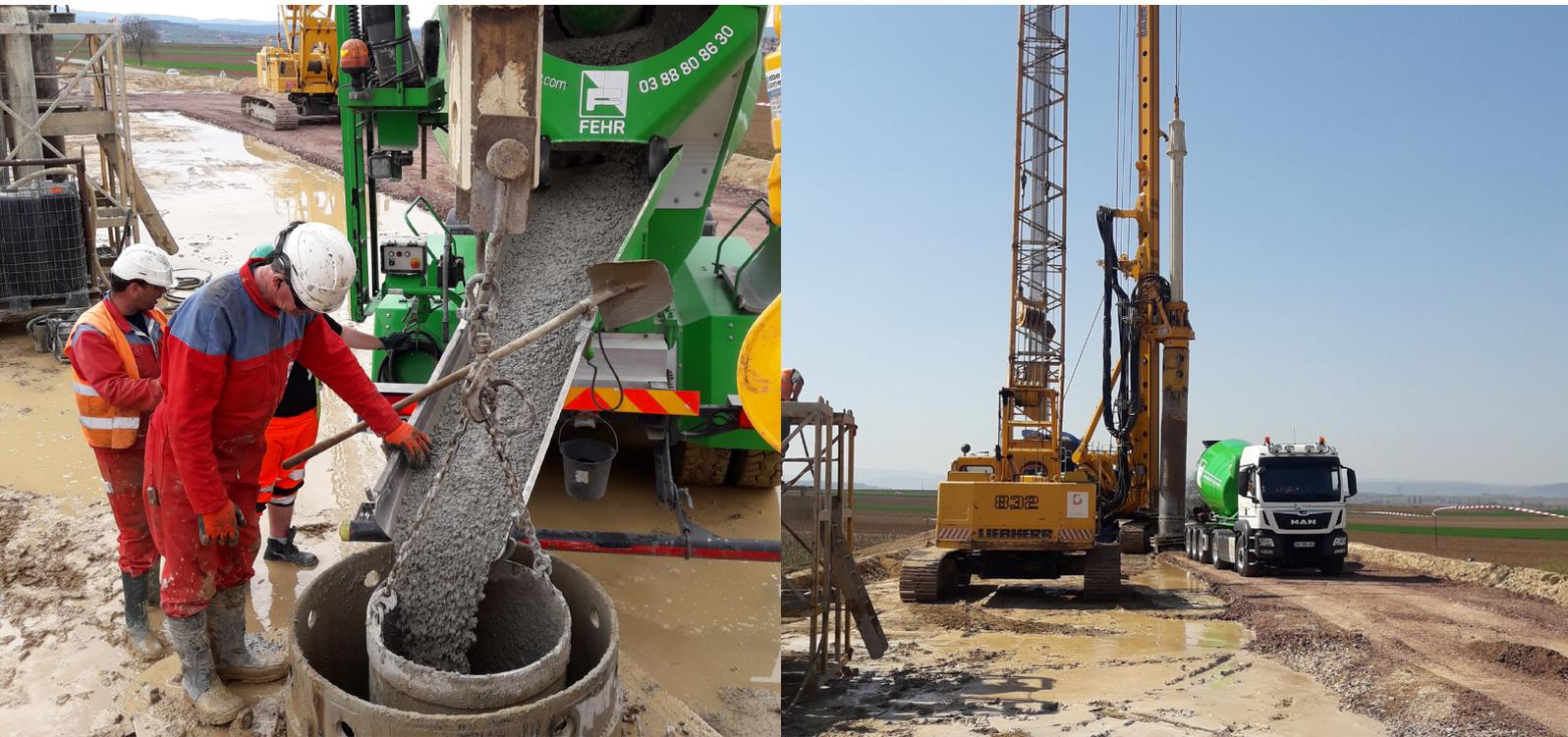
Ce type de béton est requis lorsque le sol résistant se trouve à une très grande profondeur. Il est préconisé pour réaliser notamment les fondations de structures de Génie Civil.
