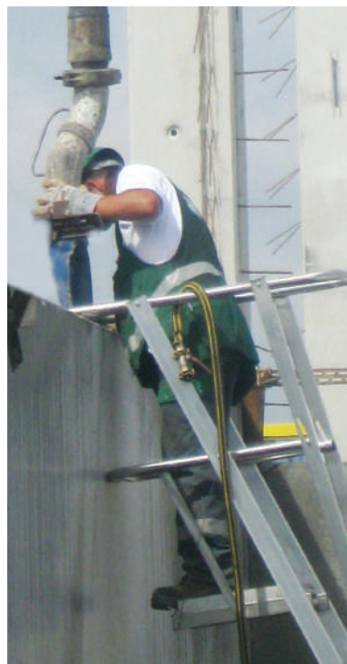
Bétonnage depuis l'AMP
