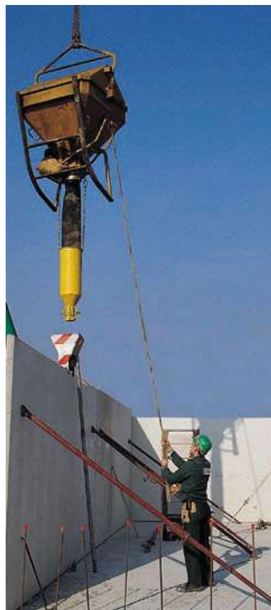
Bétonnage depuis le sol
