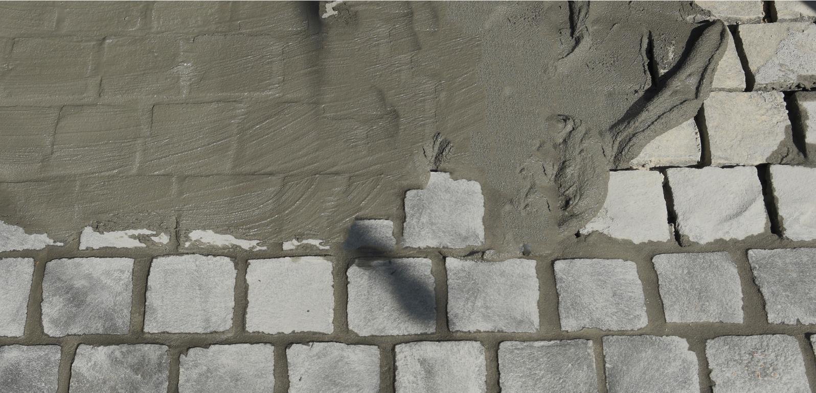
Mortier de calage et de jointoiment pour la pose de pavés, bordures et caniveaux
