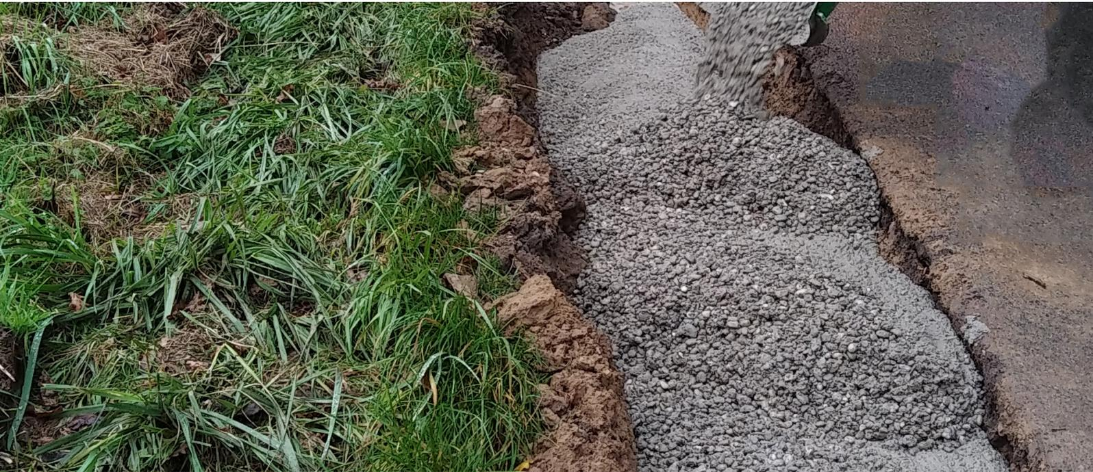
Le MACES (**M**atériau **A**uto**C**ompactant **E**ssorable de **S**tructure) est un matériau hydraulique spécialement élaboré pour éviter le compactage lors de la mise en oeuvre dans les tranchées : il se met en place par simple déversement, sans vibration.
