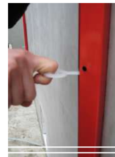
Drehen und am Dübel ziehen, um die Schalung ordnungsgemäß am Anschluss der Doppelwand zu befestigen.
