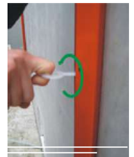
Schiene nach dem Verfugen demontieren. Dazu den Dübel drehen.
