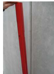
Die Schalung an der Doppelwand im Bereich des Anschlusses zwischen 2 Wänden platzieren.
