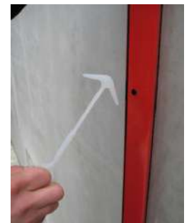
Die Befestigungsdübel in die dazu an der Schiene vorgesehenen Bohrungen einführen.
